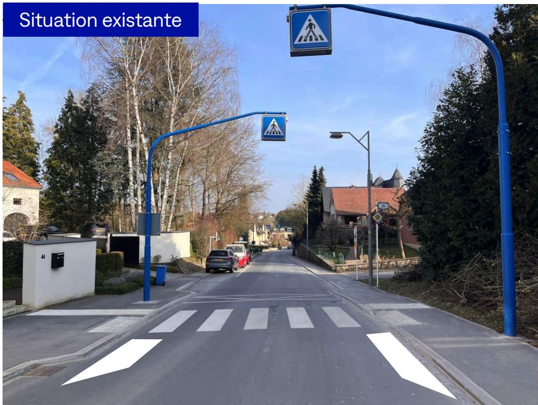
Plateau, rétrécissement ponctuel et mise en conformité du passage pour piétons récemment réalisés
